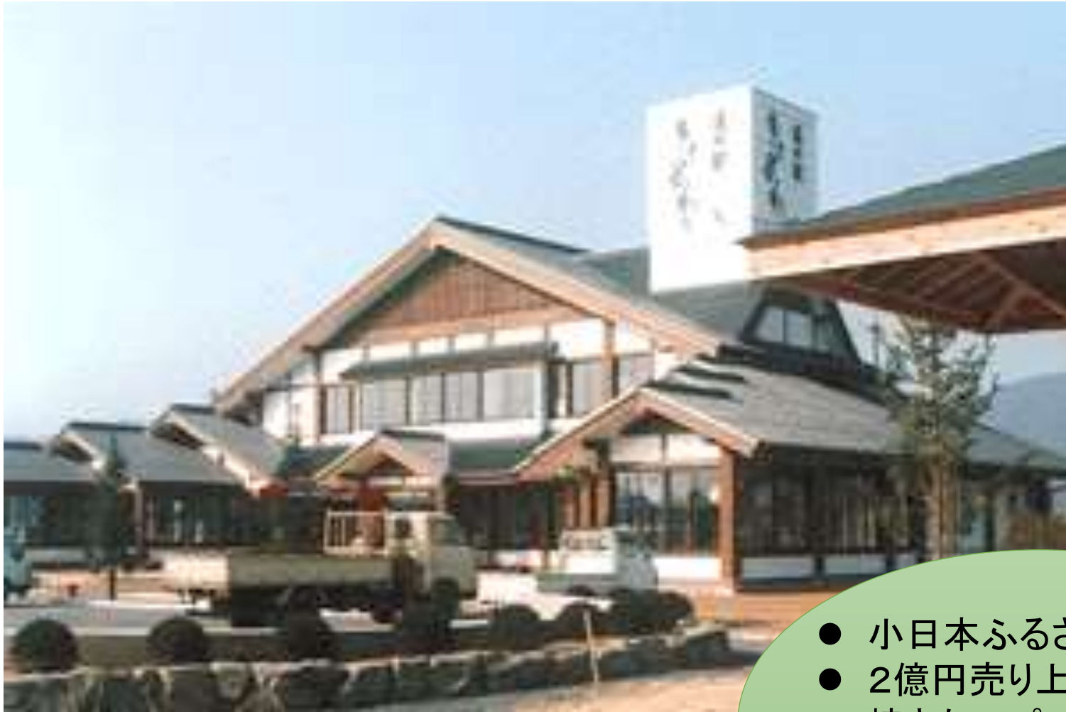
道の駅「きくがわ」 (山口県 下関市 菊川町)
